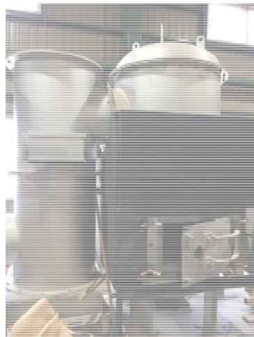
図 102 (左)薪ボイラー、(右)バイオマス利用熱風発生炉(乾燥用熱源利用の例)
