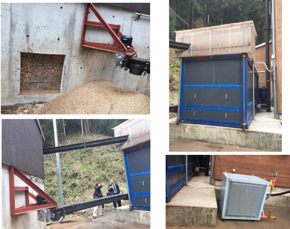
図 41 (上左)燃料用チップ一次貯留脇壁面の通風孔、(上右)通風乾燥設備
