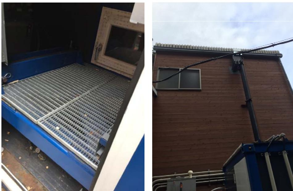
図 42 (左) 通風乾燥設備内部、(右) 通風乾燥設備から燃料サイロ(2F)への搬送フィーダ
