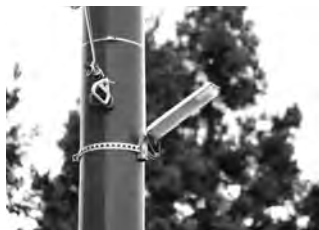
防犯灯設置・地区集会所改修 815万円
