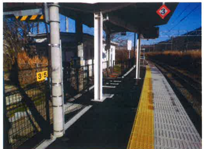
古間駅 施工後 (黒姫方)
