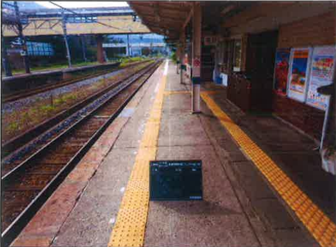
黒姫駅 施工前 (上りホーム)
