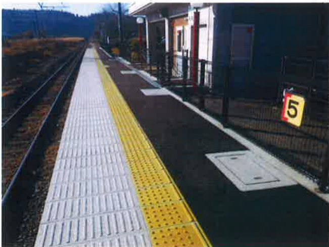
古間駅 施工後 (長野方)
