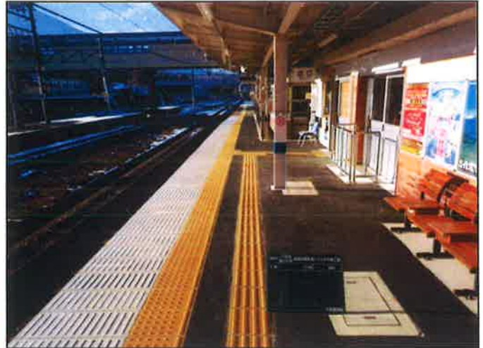
黒姫駅 施工後 (上りホーム)
