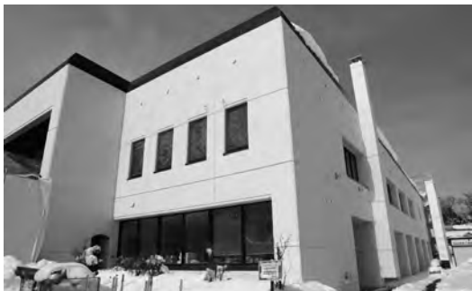
アスベスト除去や亀裂補修を行った外壁
