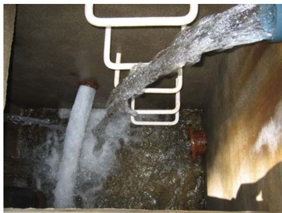
柏原弘法清水水源（集水井）
