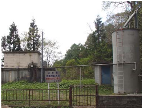
荒瀬原浄水場
