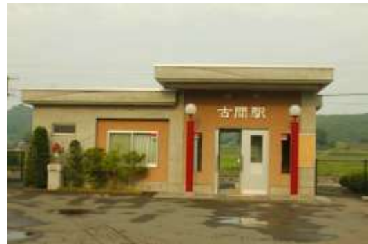
写真 4-11. 古間駅の駅舎
