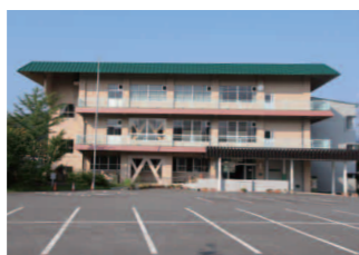
野尻湖支館耐震補強工事 6,410万円
