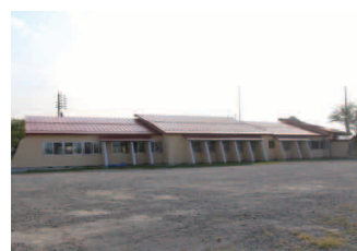
保育園施設整備工事 6,160万円
