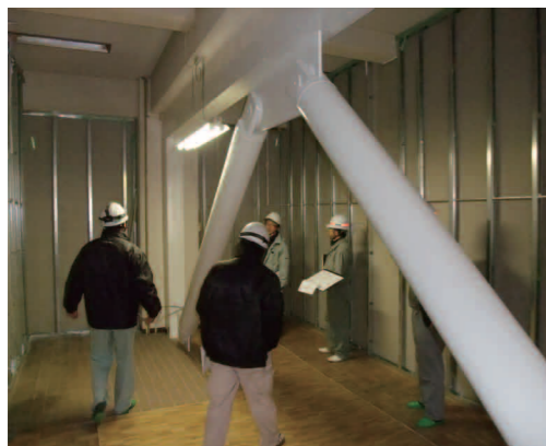
耐震部材のアルミ製ブレースの設置状況
