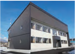
雇用促進住宅建設工事 9,337 万円
