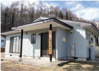
移住体験施設整備工事 1,378 万円
