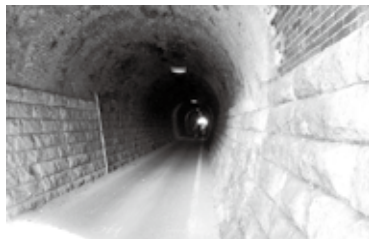
戸草トンネルの内部 (下部は切石、上部はレンガ)
