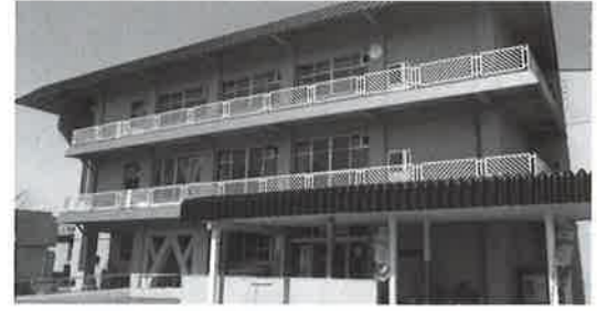
耐震化された野尻湖支館
