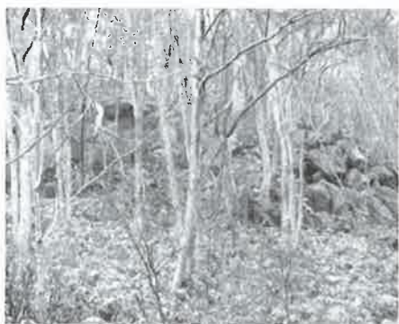
落石危険箇所県道96号線(サレジオ教会付近)
