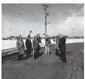
道路改良の現場
