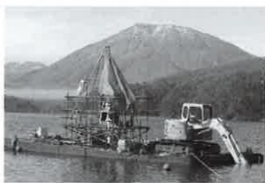
菅川橋実現に向けて地質調査
