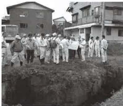
改修が必要な池尻川
