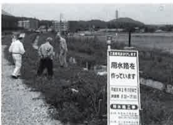
用水改修工事中
