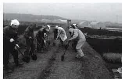
地域で道路補修
