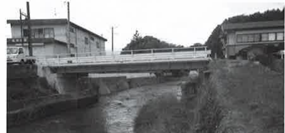
長寿命化計画により改修された上島橋
