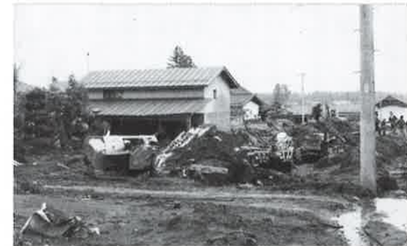
29年前の土石流災害（板橋組）
