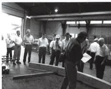
集成材の縦継ぎ作業場
