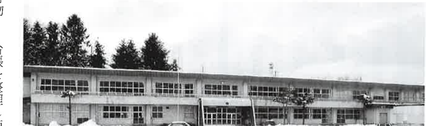
資料保管庫として利用される予定の旧野尻湖小学校
