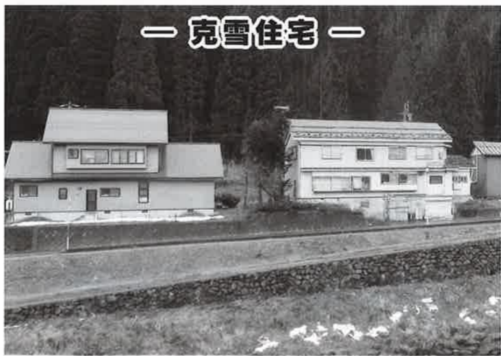
右側の住宅は「融雪式屋根」といい、熱で屋根雪を融かす屋根です。左側の住宅は「自然落雪式屋根」といいます。
