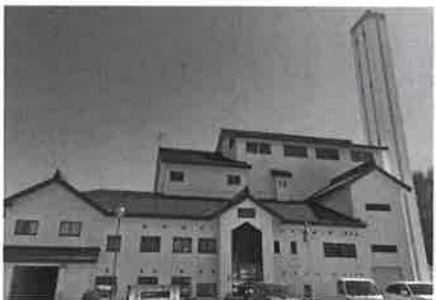
解体予定の北部衛生クリーンセンター
