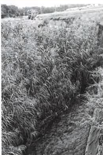
待たれるしゅんせつ工事と護岸工事
