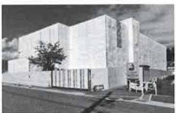
工事中の総合会館
