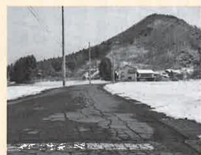
新しい制度を活用して、「亀の甲」状になった道路の舗装面を改修します
