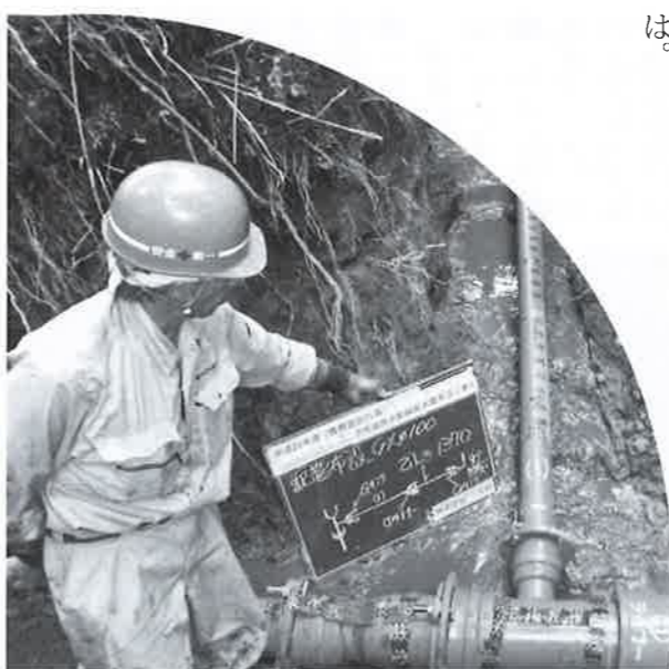
最新の耐震管に交換する工事が進んでいます
