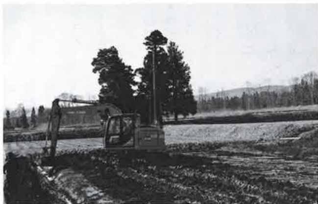
農地の排水・改良工事
