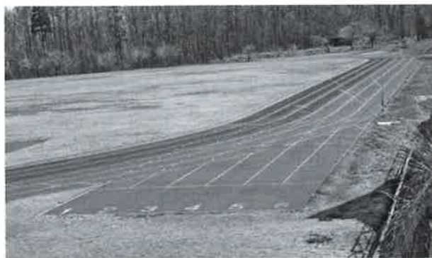
合宿誘致の強化を 改修予定の陸上トラック
