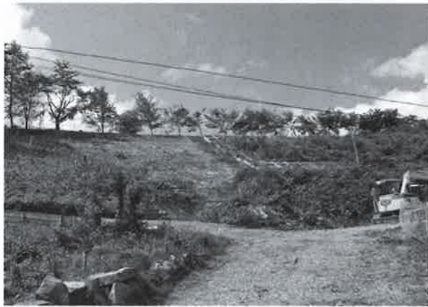
古間地区急傾斜地
