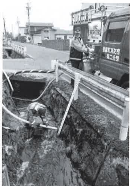
消防団による溜まった土砂の除去作業
