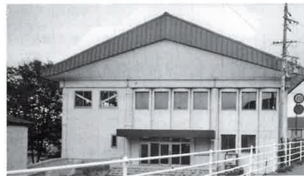
避難所となっている旧柏原小体育館
