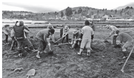
埋め戻しの作業
