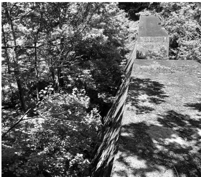
町職員が確認した屏風沢砂防堰堤（えんてい）
