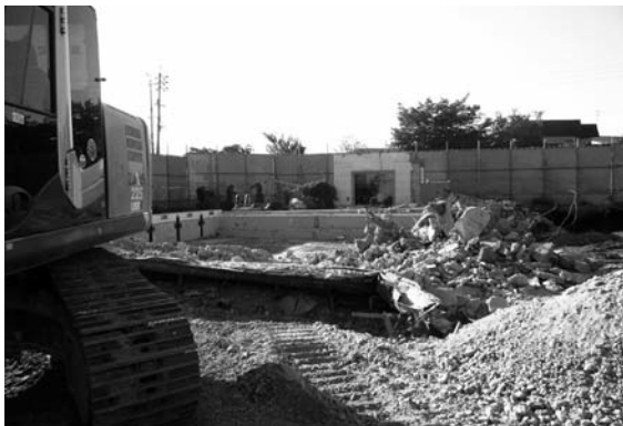
旧柏原小学校プールの解体
