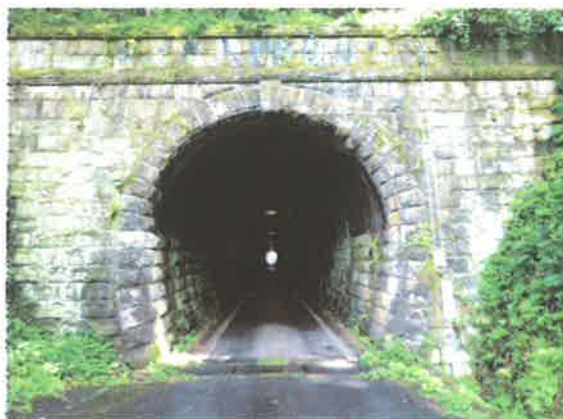
図 1-1 戸草トンネル南側坑門部
