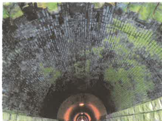
図 1-2 戸草トンネル覆工レンガ部
