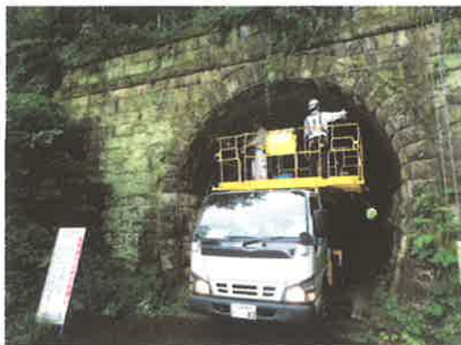
図 2-2 定期点検状況
