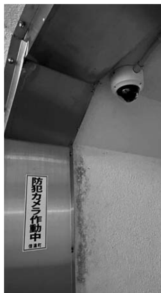
黒姫駅南横断地下道 防犯カメラ
