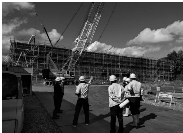
建築現場の様子（10月11日現在）
