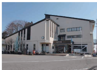
役場庁舎耐震補強工事 2億3,260万円
